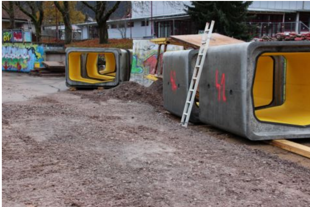
Von der Erstlieferung mit 48 Kanalstücken sind 40 bereits unter dem Boden
