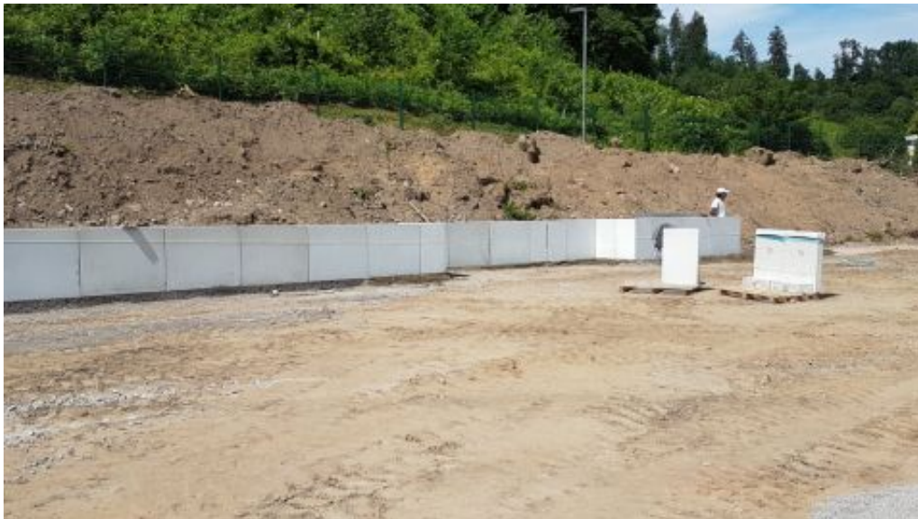
zweiten Kleinspielfeld die Mauerscheiben gesetzt werden...
